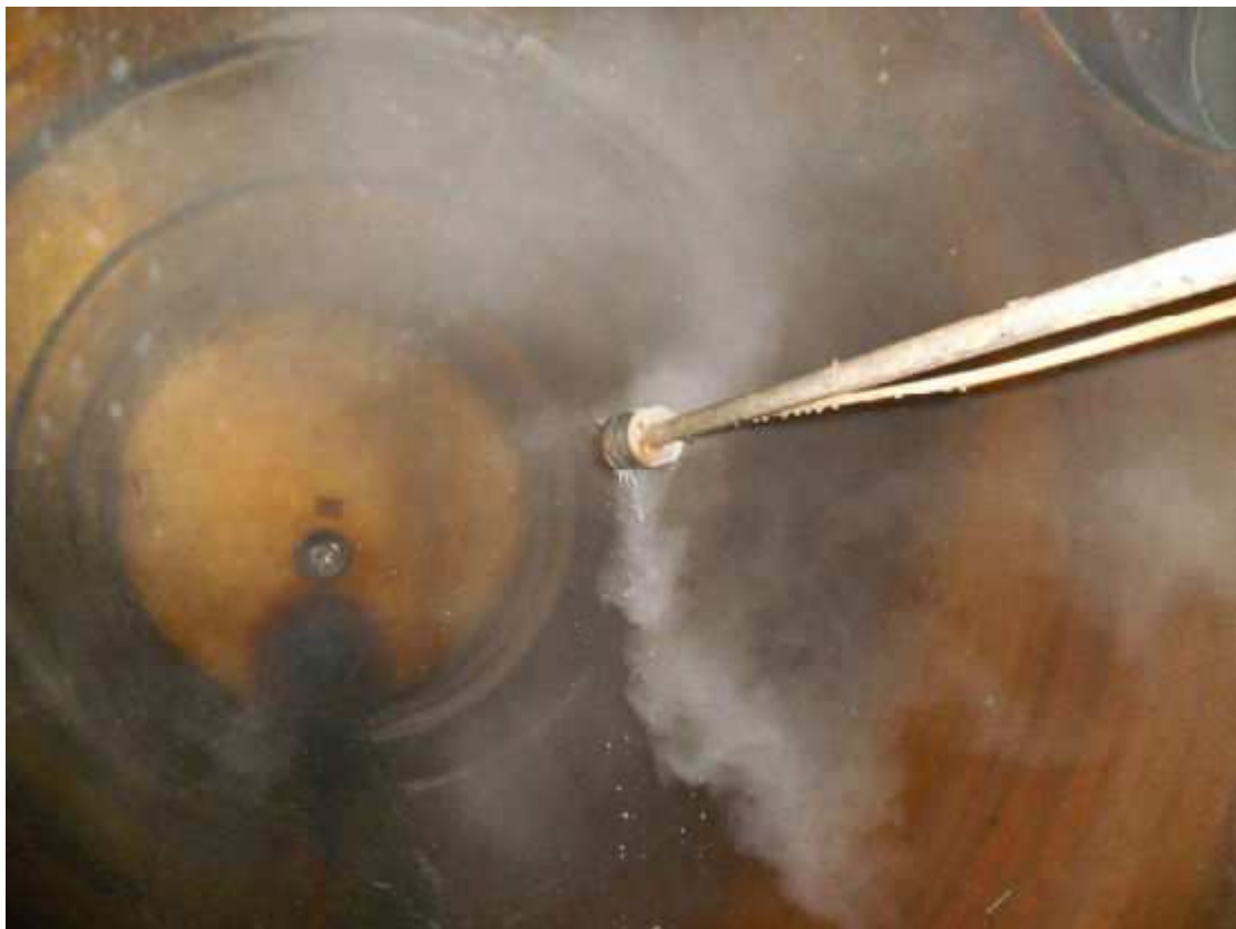
Interno camera deodorizzazione, flusso nebulizzato.
