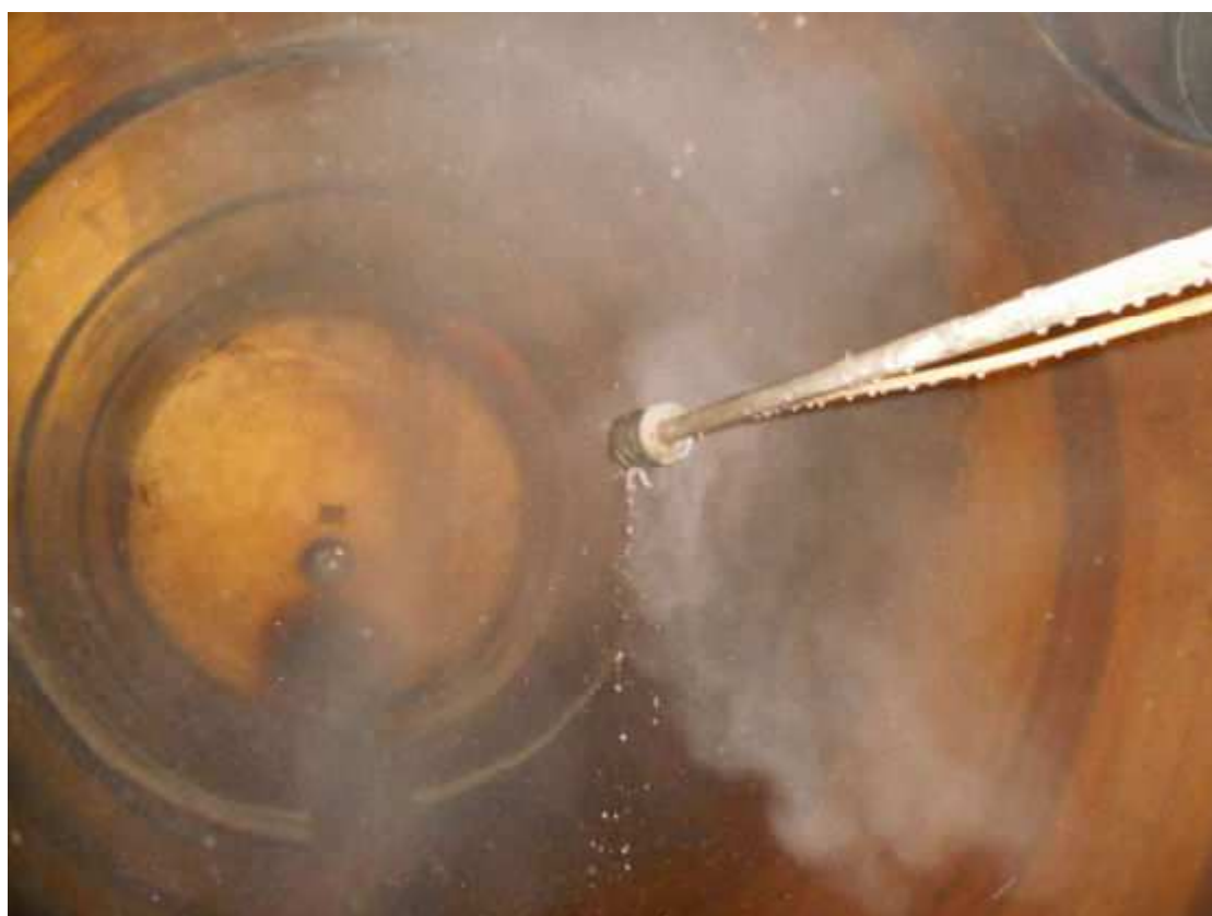
Interno camera deodorizzazione, flusso nebulizzato.
